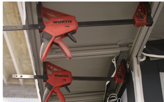
*8 - Spänn upp taket på utsidan vid frontväggen med hjälp av två tvingar.
