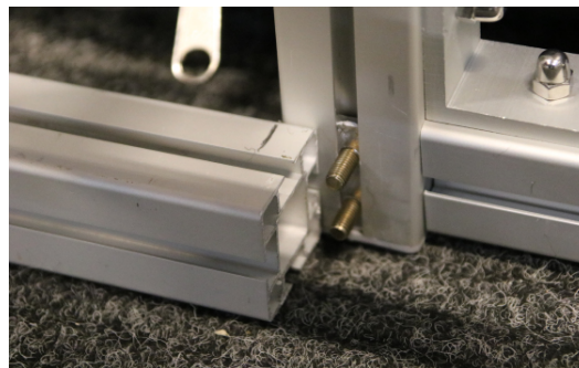
*8 - Använd en tving om det är svårt att få tvärstagen på plats. Här kan profil behöva anpassas och kapas om den är för lång
