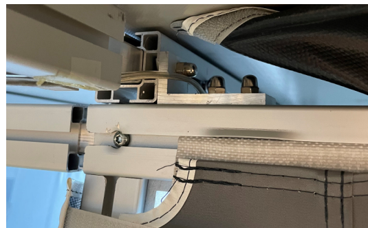
*8 - De två takstolarna ska nu fästas på frontväggens överliggare genom att lägga i en T-skruv och sedan fästa i tredje B-vinkeln från respektive kant.
