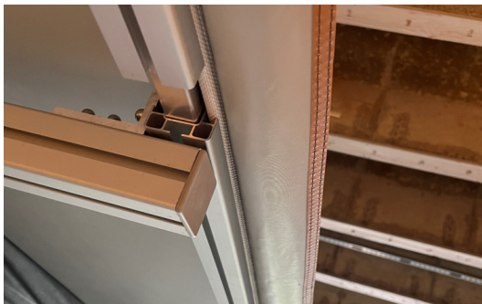
*4 - Gör en vändning på takstolarna så att vulster hamnar utåt på sidan.
